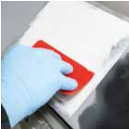
Auftragen von Feinspachtel TEROSON UP 335 FF
