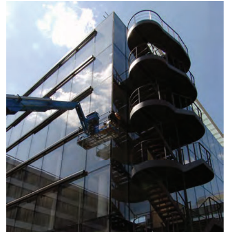
Abb. 1: Baustellenverklebung an einer Fassadenecke, Neubau HDI-Gerling Zentrale Hannover
